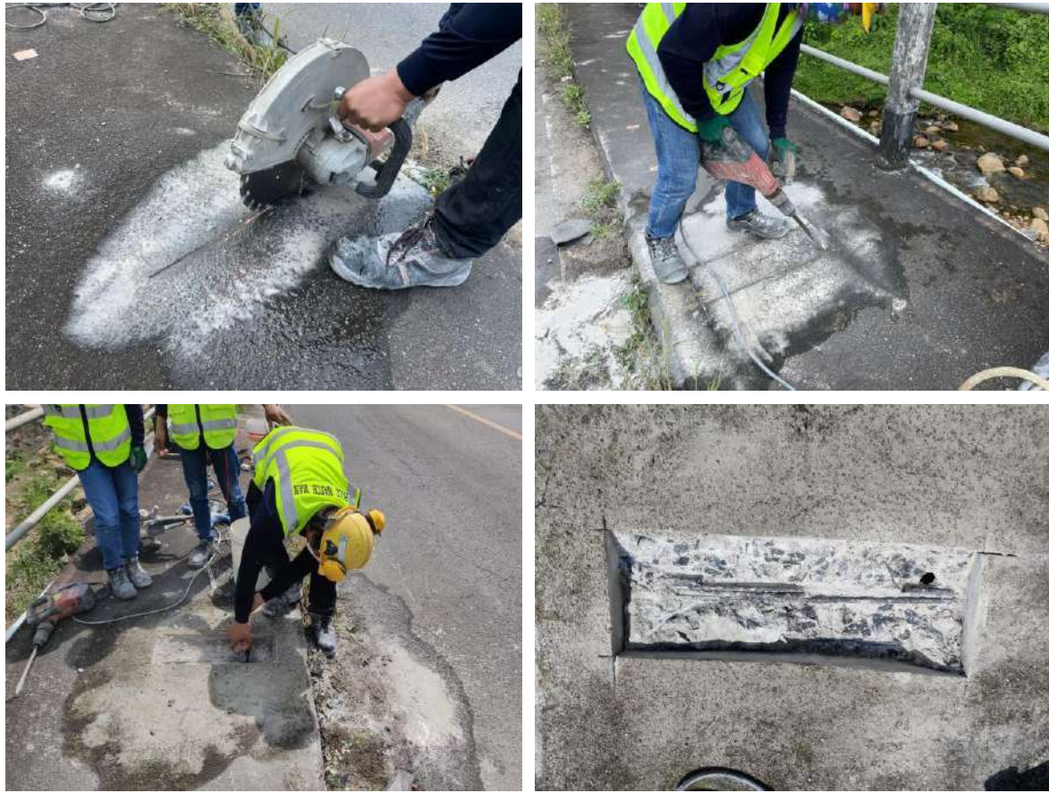
รูปที่ 4-10 รูปการทำงานเก็บวัสดุทดสอบกำลังเหล็กเสริม
