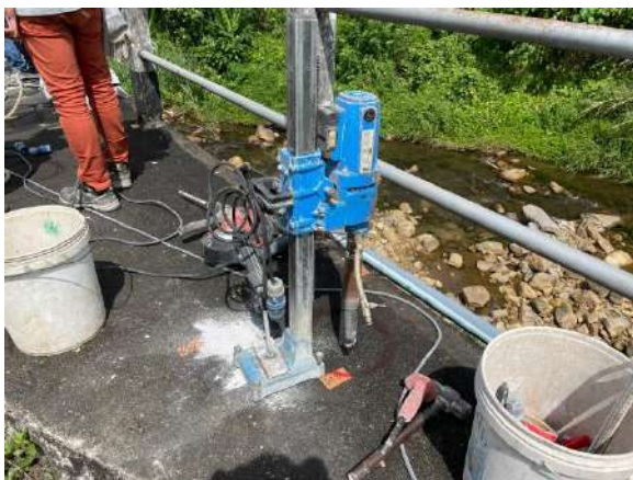
(ก) เครื่องเจาะเก็บแท่งตัวอย่างคอนกรีต
