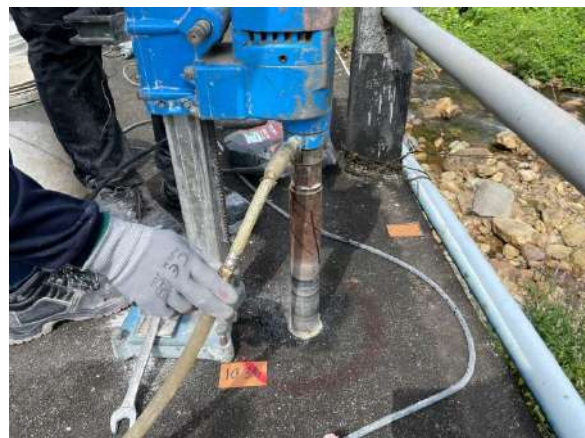
(ข) การเก็บแท่งตัวอย่างคอนกรีต
