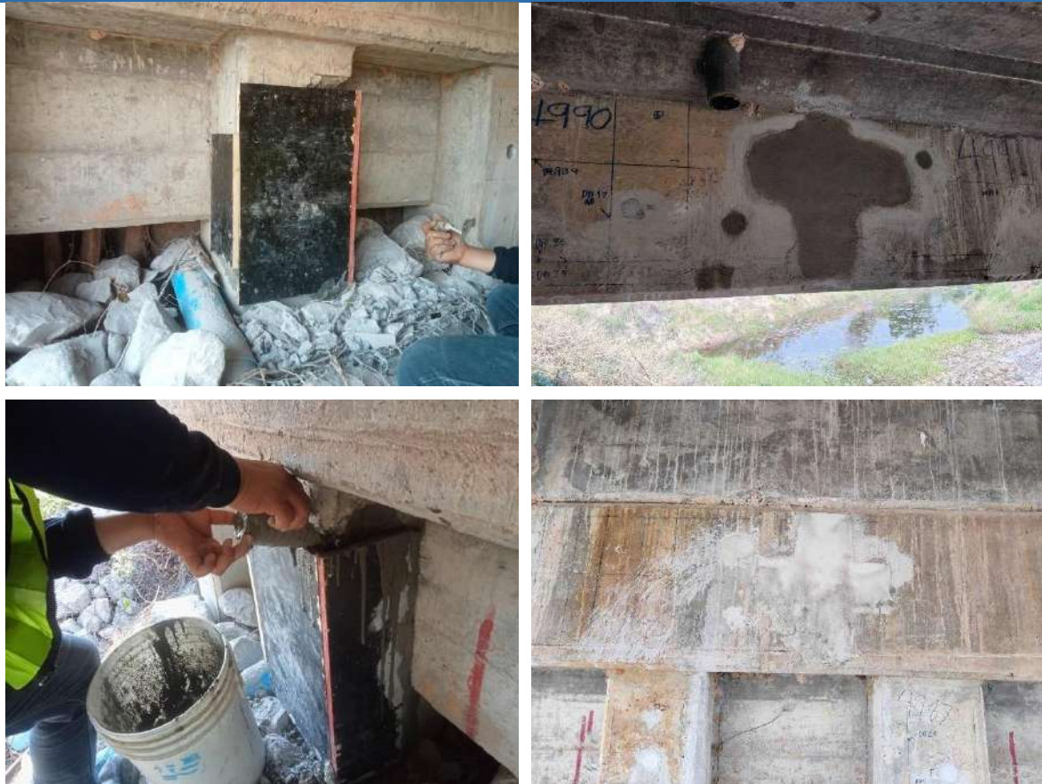
รูปที่ 6-11 รูปการซ่อมคืนสภาพจากการเก็บวัสดุทดสอบกำลังเหล็กเสริม
