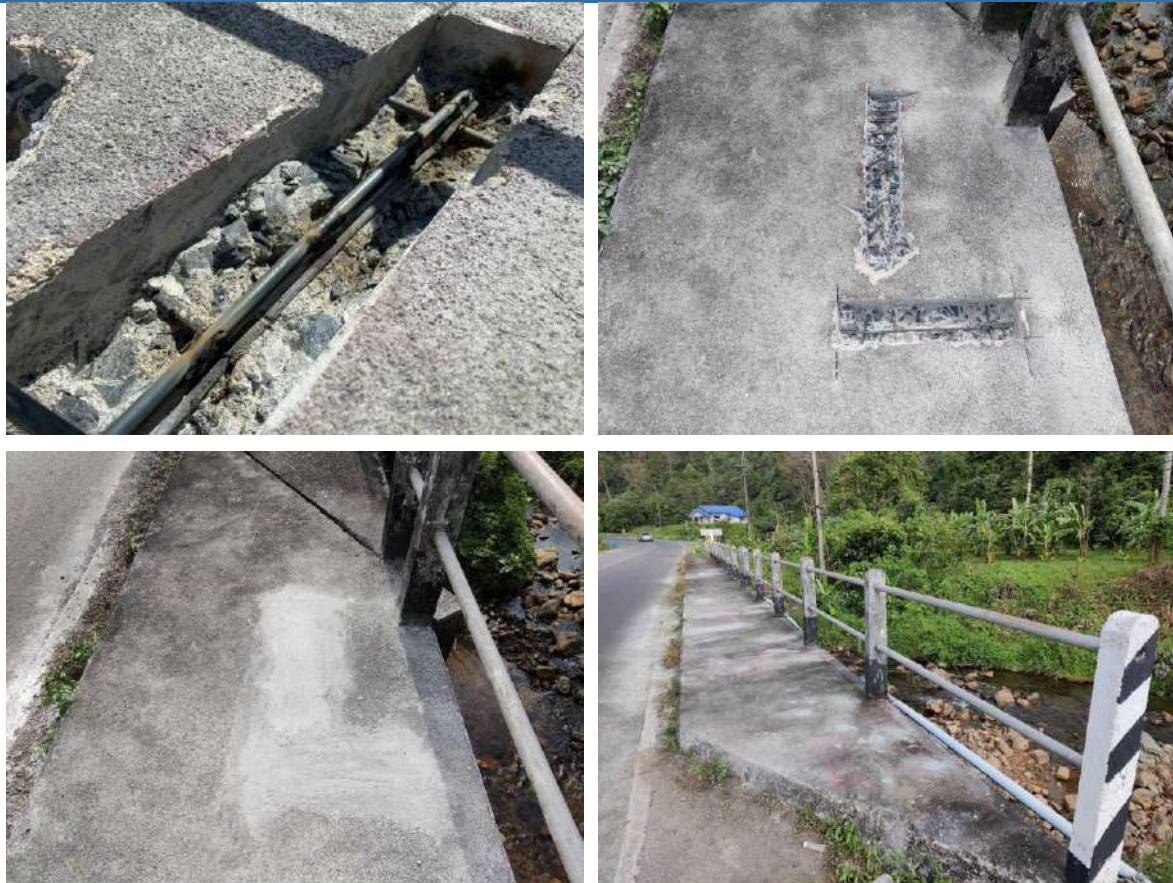
รูปที่ 4-11 รูปการซ่อมคืนสภาพจากการเก็บวัสดุทดสอบกำลังเหล็กเสริม
