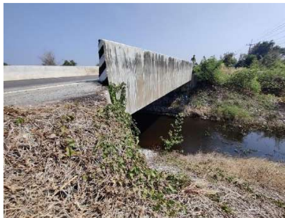
รูปที่ 6-1 รูปทั่วไปของสะพานห้วยเงิน
