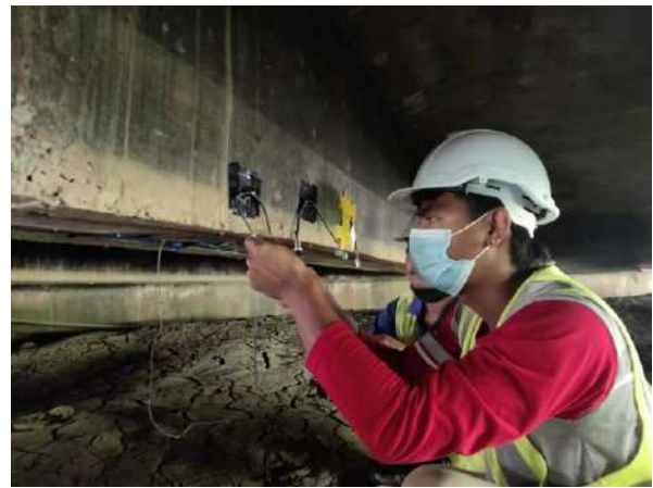
รูปที่ 5-14 ภาพการติดตั้งอุปกรณ์ตรวจวัดสะพาน
