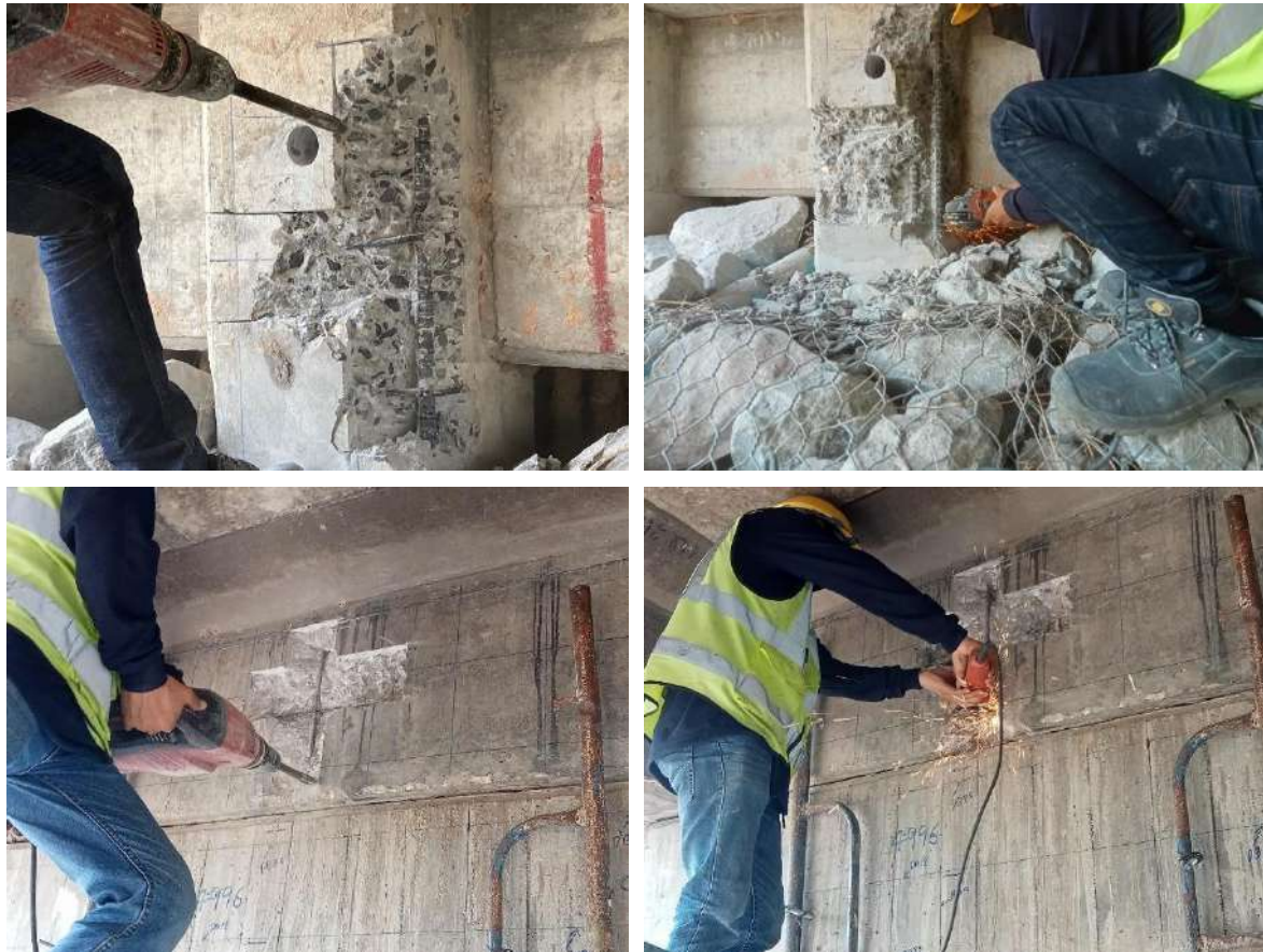
รูปที่ 6-10 รูปการทำงานเก็บวัสดุทดสอบกำลังเหล็กเสริม
