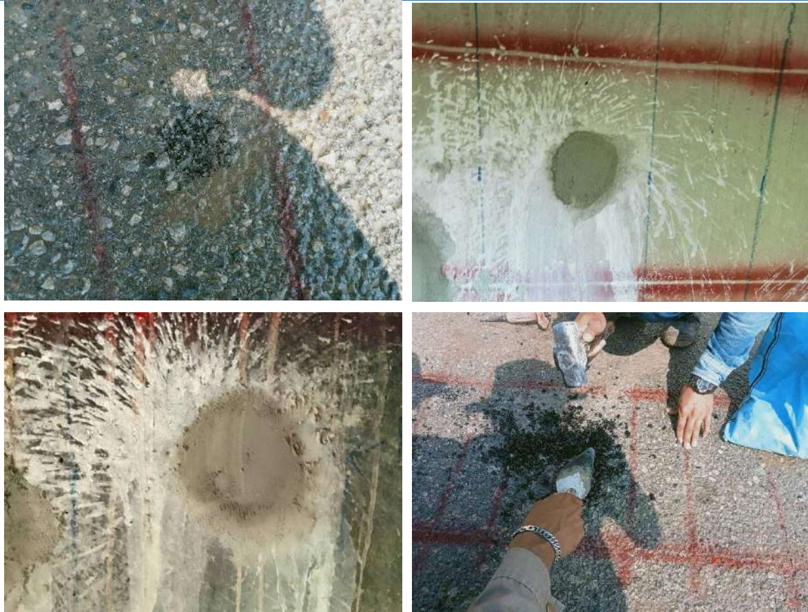
รูปที่ 5-9 รูปการซ่อมคืนสภาพจากการเก็บวัสดุทดสอบกำลังคอนกรีต
