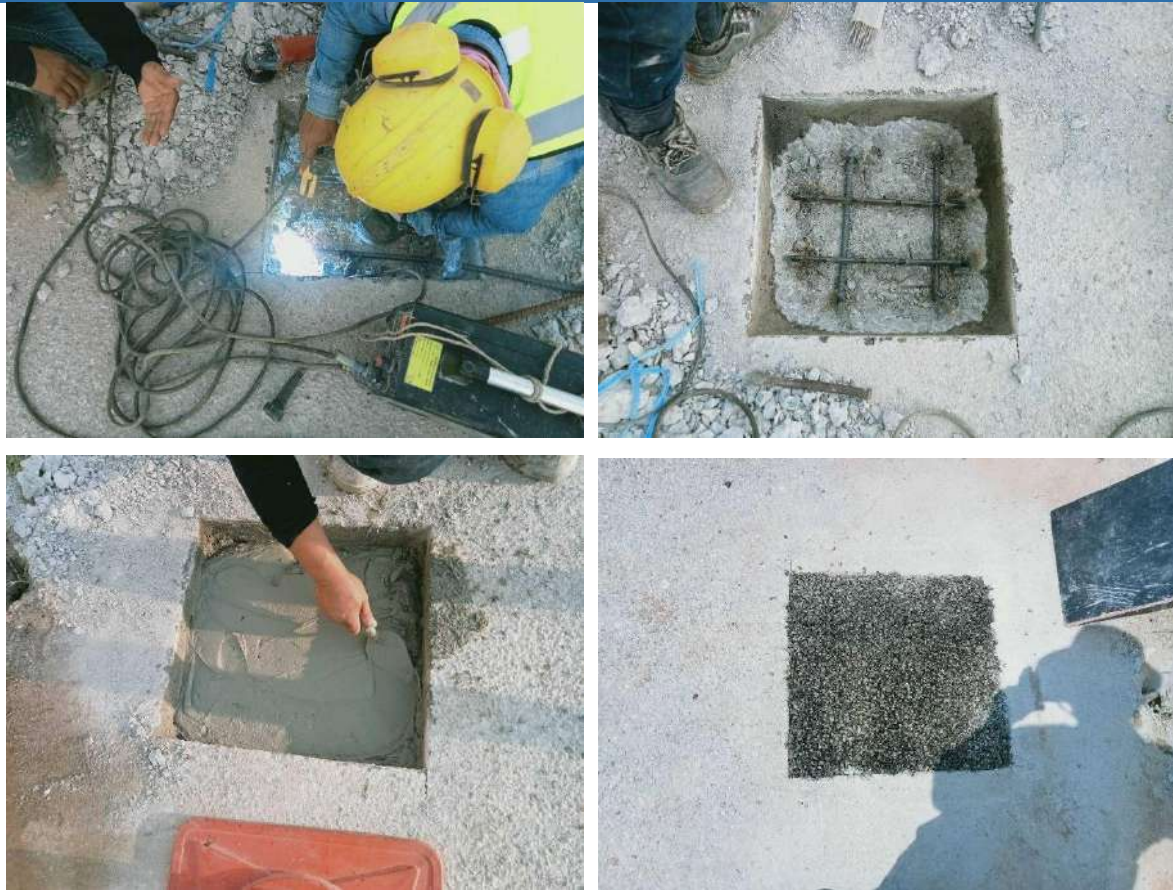
รูปที่ 5-11 รูปการซ่อมคืนสภาพจากการเก็บวัสดุทดสอบกำลังเหล็กเสริม
