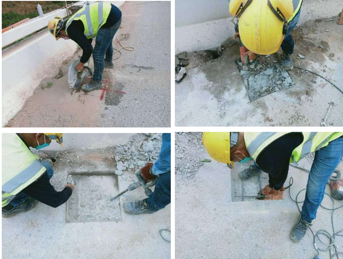
รูปที่ 5-10 รูปการทำงานเก็บวัสดุทดสอบกำลังเหล็กเสริม
