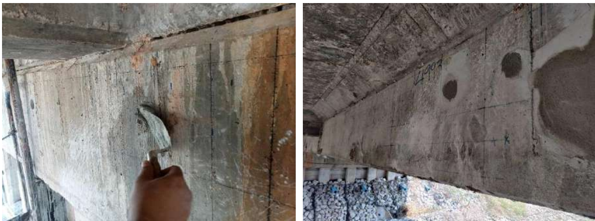
รูปที่ 6-9 รูปการซ่อมดินสภาพจากการเก็บวัสดุทดสอบกำลังคอนกรีต
