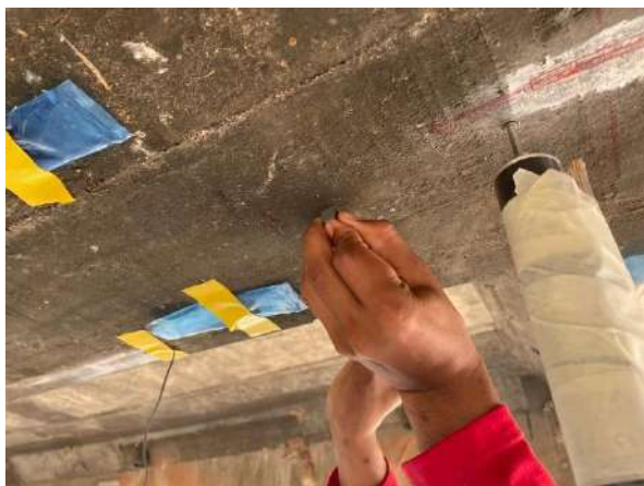
รูปที่ 6-14 ภาพการติดตั้งอุปกรณ์ตรวจวัดสะพาน
