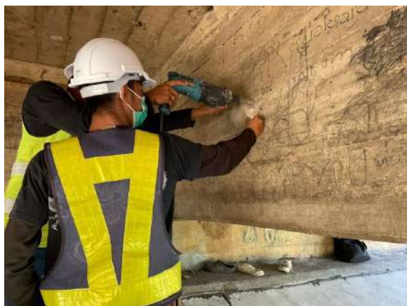
(ก) การเจาะเก็บตัวอย่างคอนกรีต
