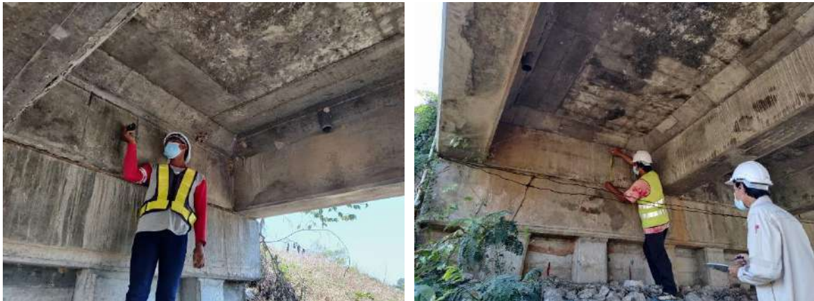
รูปที่ 6-2 การตรวจวัดมิติของสะพาน (ทั่วไป)
