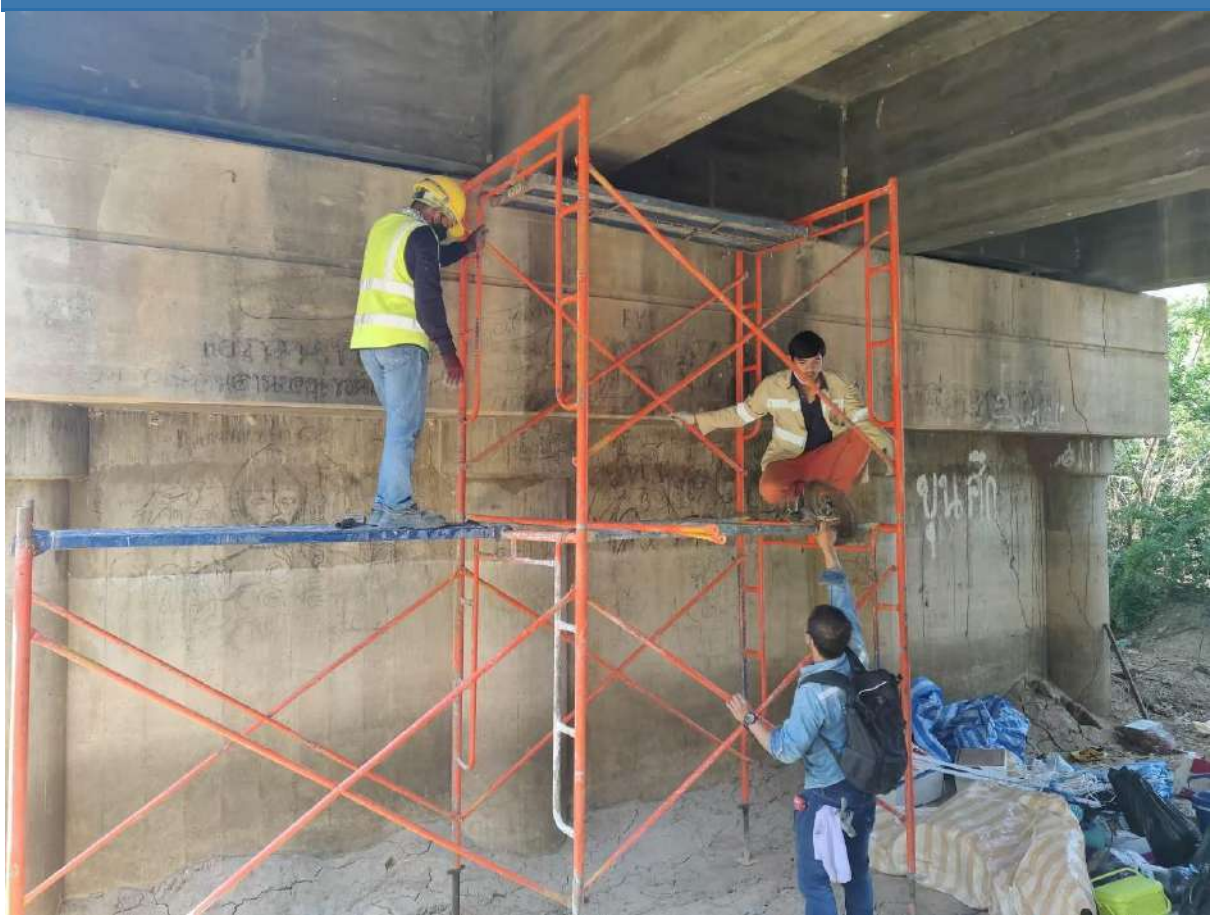
รูปที่ 3-2 ตัวอย่างการตั้งนั่งร้านสำหรับการตรวจวัดมิติของสะพาน
